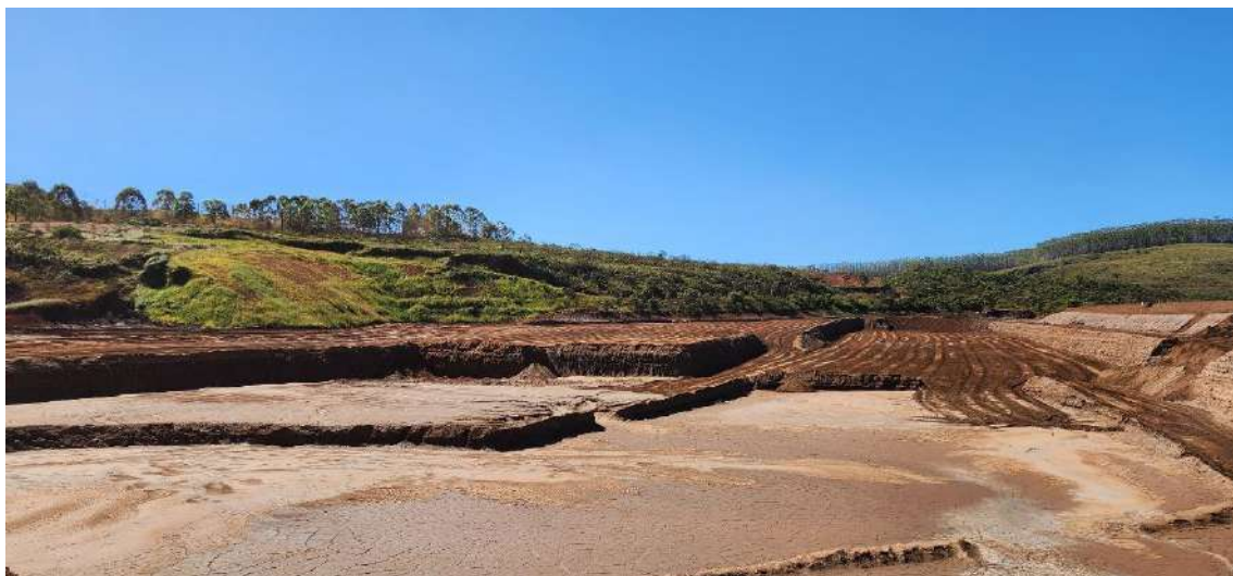
Figura 43 – Vista da bacia de acumulação de rejeitos da Barragem B4, em processo de descaracterização, observando-se os cortes realizados por escavação mecânica para remoção dos materiais e encaminhamento para a planta de beneficiamento.
