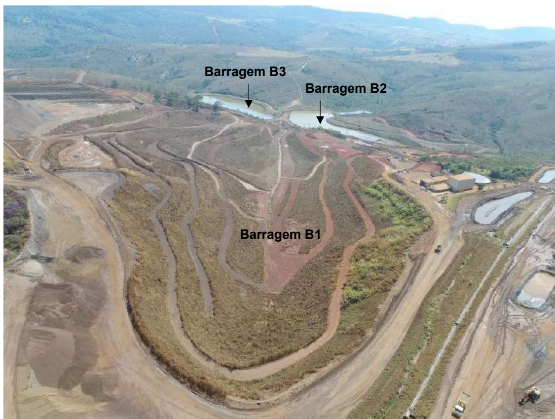
Figura 36 - Vista aérea panorâmica próxima da área da Barragem B1, já oficialmente descaracterizada, destacando-se sua total reconformação, com a retirada dos rejeitos remanescentes, implantação de sistema de drenagem e revegetação, observando-se ao fundo as barragens B2 e B3.
