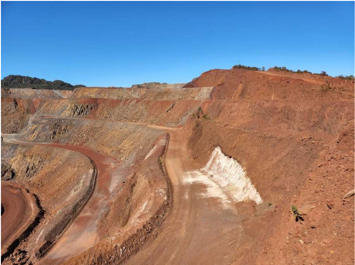
Figura 20 - Foto ilustrativa das bancadas da lavra do Sapecado.
