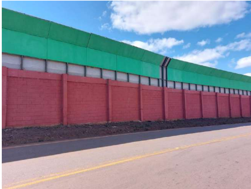
Figura 62 – Muro recém reestruturado, reforçado e com altura aumentada, em grande extensão na divisa da via com as habitações vizinhas.
