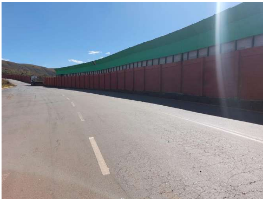
Figura 63 – Vista da extensão da via mais próxima à BR-040, mostrando o bom acréscimo na altura do muro, o que pode ser conferido ao fazer um comparativo do mesmo em relação à altura do caminhão que está na via.
