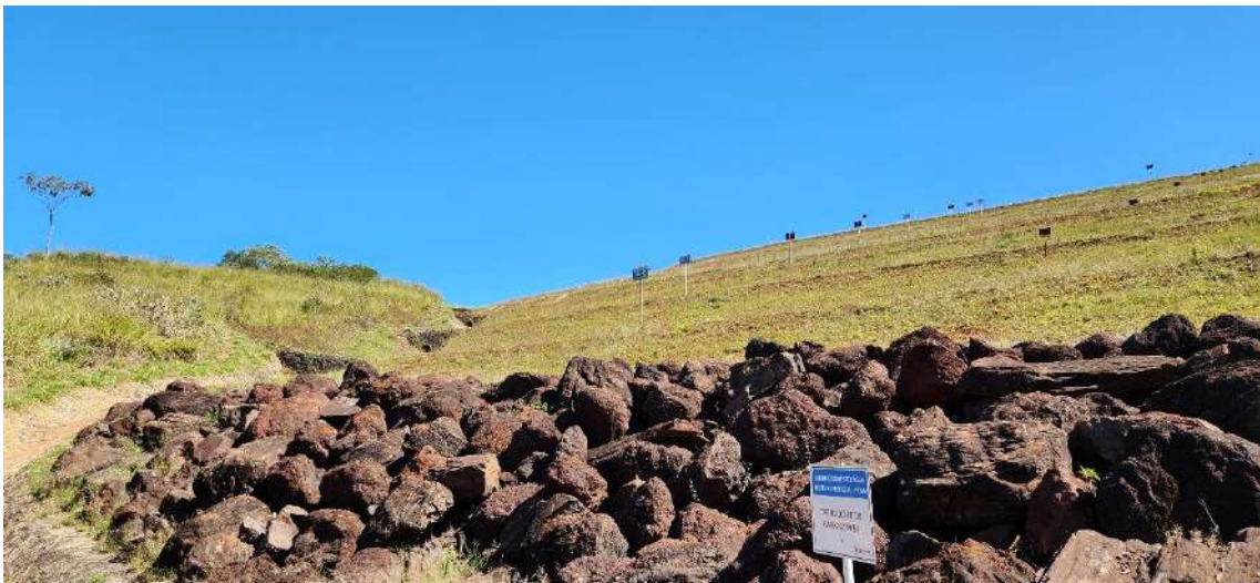
Figura 42 – Vista do taludes de jusante da Barragem B4, observando-se a estrutura filtrante em sua base (blocos de enrocamento).
