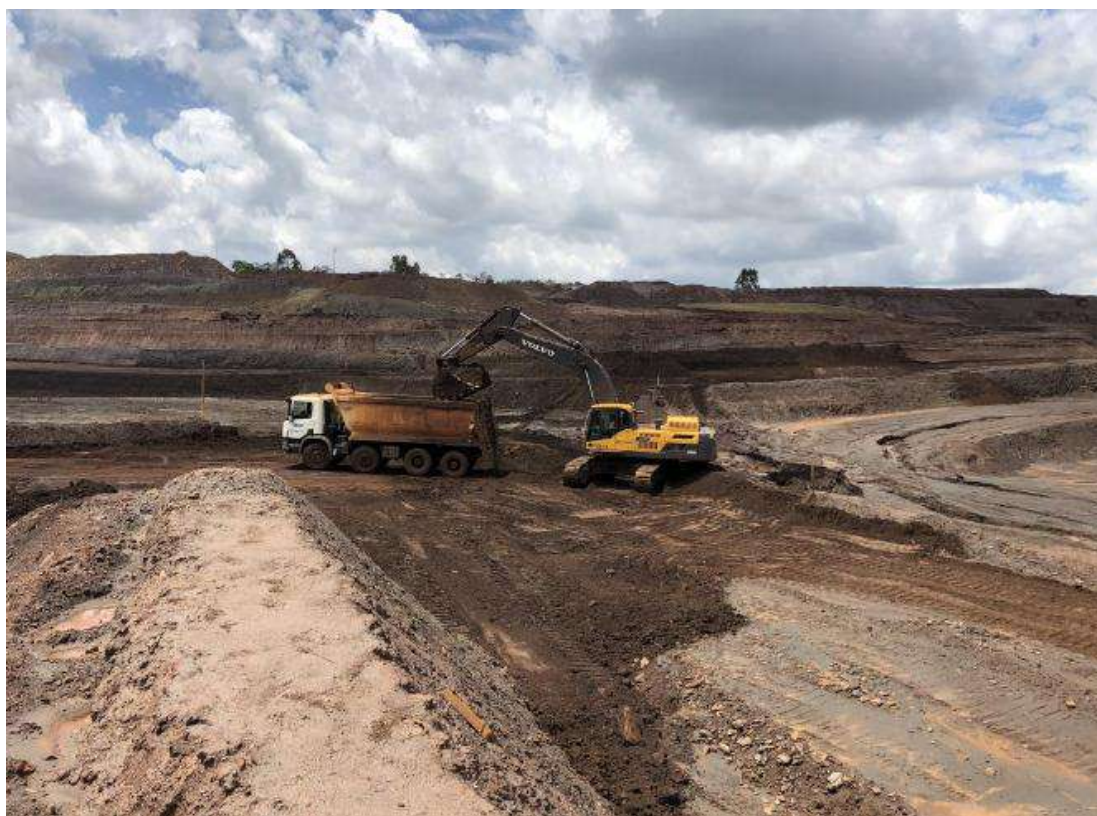
Figura 33 - Registro fotográfico da remoção dos rejeitos da Barragem B1.
