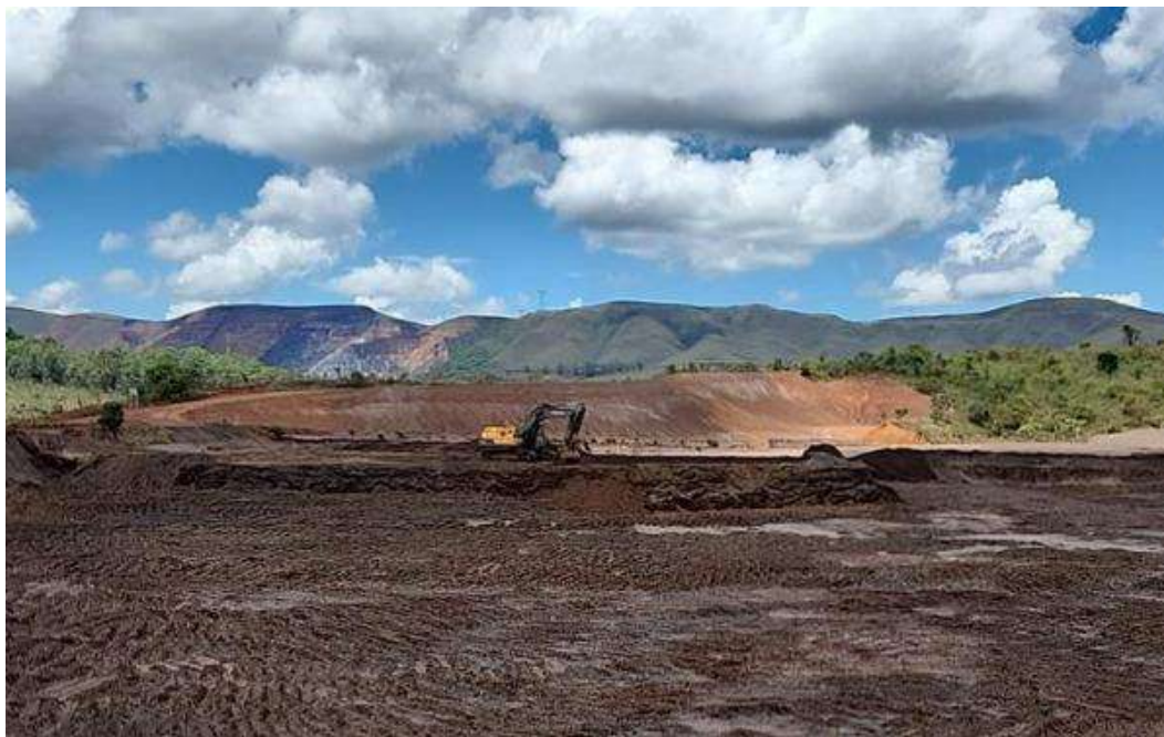
Figura 44 – Retomada dos rejeitos da Barragem B4.
