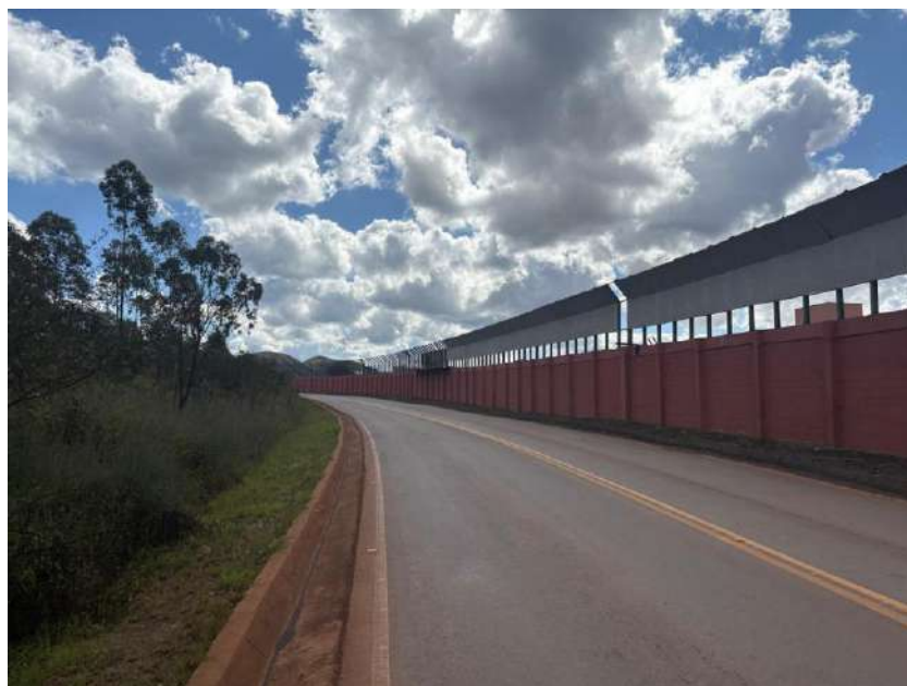
Figura 61 – Detalhe do muro de alvenaria e do bom aspecto das vias de rolamento e das canaletas laterais de drenagem da via de ligação entre a HERCULANO e a BR-040.
